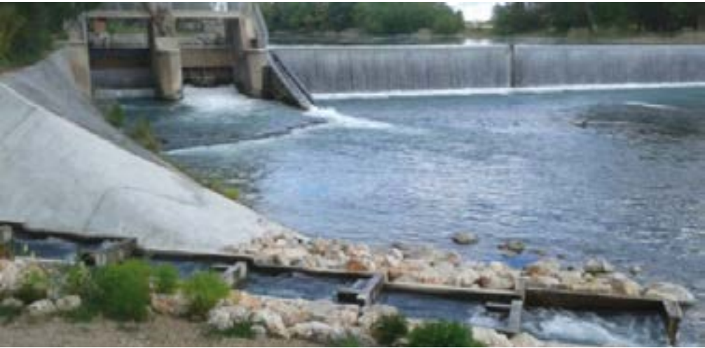
Paso para peces en la presa de Estremera. Río Tajo (Guadalajara).
